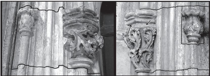
**Fig. 2** – À esquerda, capitel manuelino da edícula norte. À direita, capitel flamejante da edícula sul cujo ábaco foi adaptado ao gosto manuelino, tendo sido introduzido um novo elemento, em cima à direita, cujas juntas se assinalam. As setas indicam os vestígios de formas rectilíneas do ábaco e do topo do cesto flamejante.
