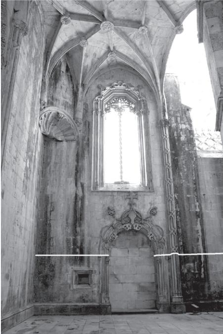
Fig. 4 – Parede sul do átrio. Linha divisória entre a construção flamejante e a manuelina.
