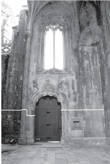
Fig. 3 – Parede norte do átrio. Linha divisória entre a construção flamejante e a manuelina.
